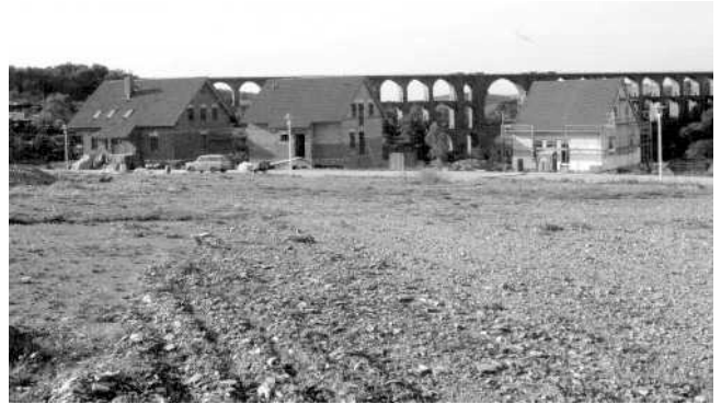
Das Wohngebiet Göltzschtalblick im Oktober 1995
