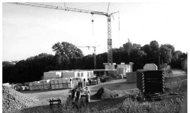
Die Baustelle des Pflegeheimes im Oktober 1995.
