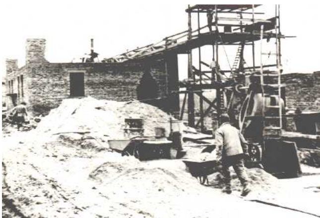
Während der Bauarbeiten der Wohnblocks.
